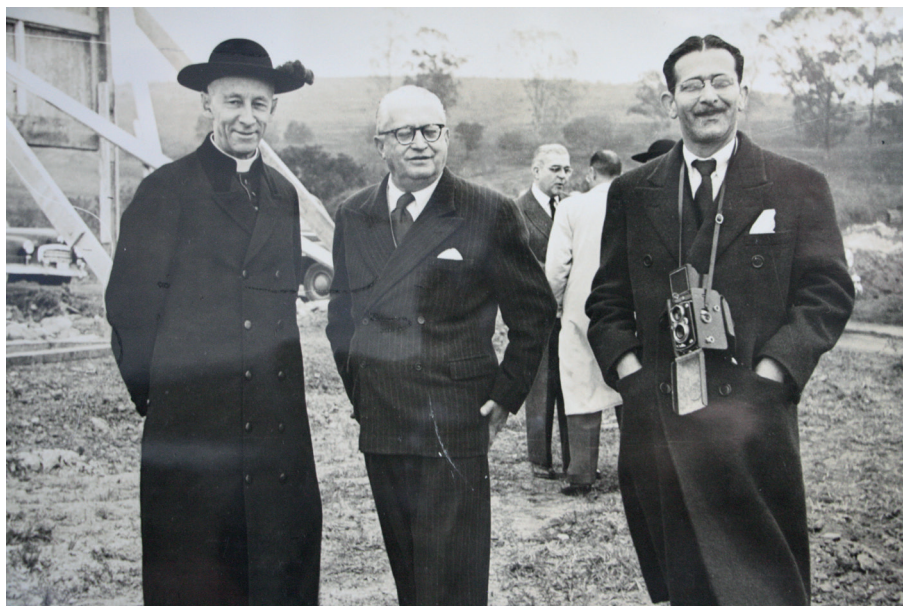
Ernesto de Souza Campos acompanha obras de construção da PUC - São Paulo
